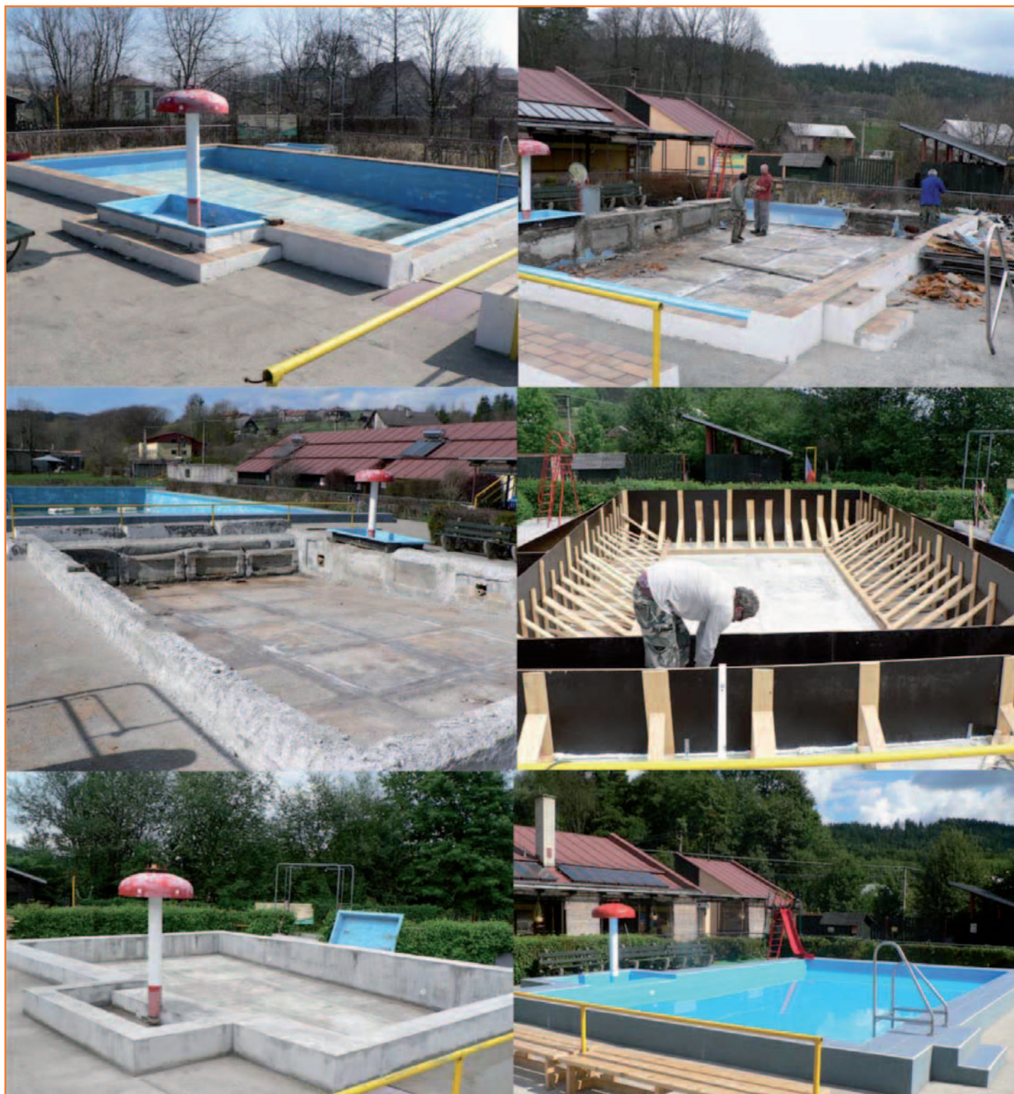
Průběh oprav dětského bazénu
